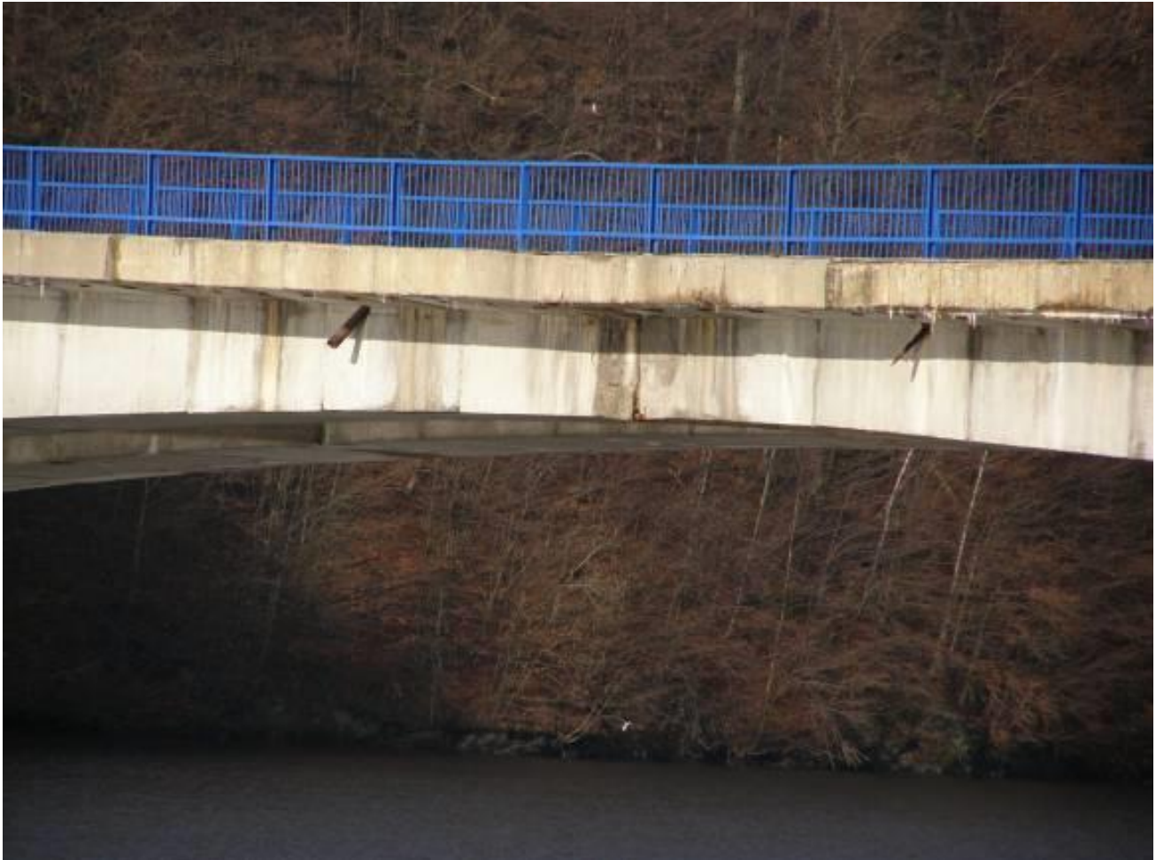
Deformácia v strede mosta
